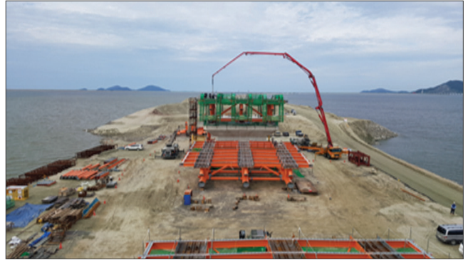
• STEP 2 _ 주두부 상현재 콘크리트 타설
