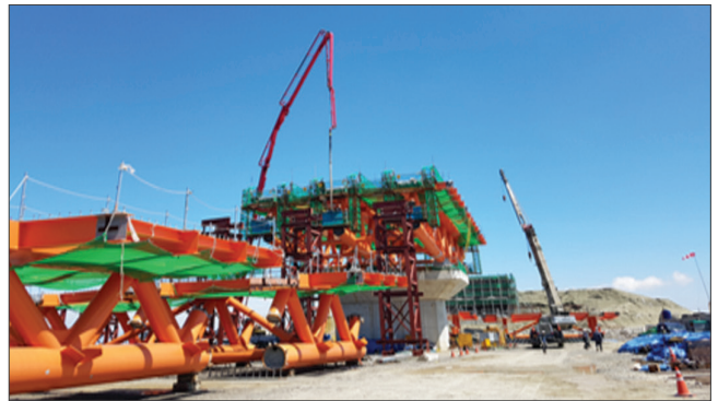
• STEP 4 _ SEG.1 상현재 콘크리트 타설 (과정반복)
